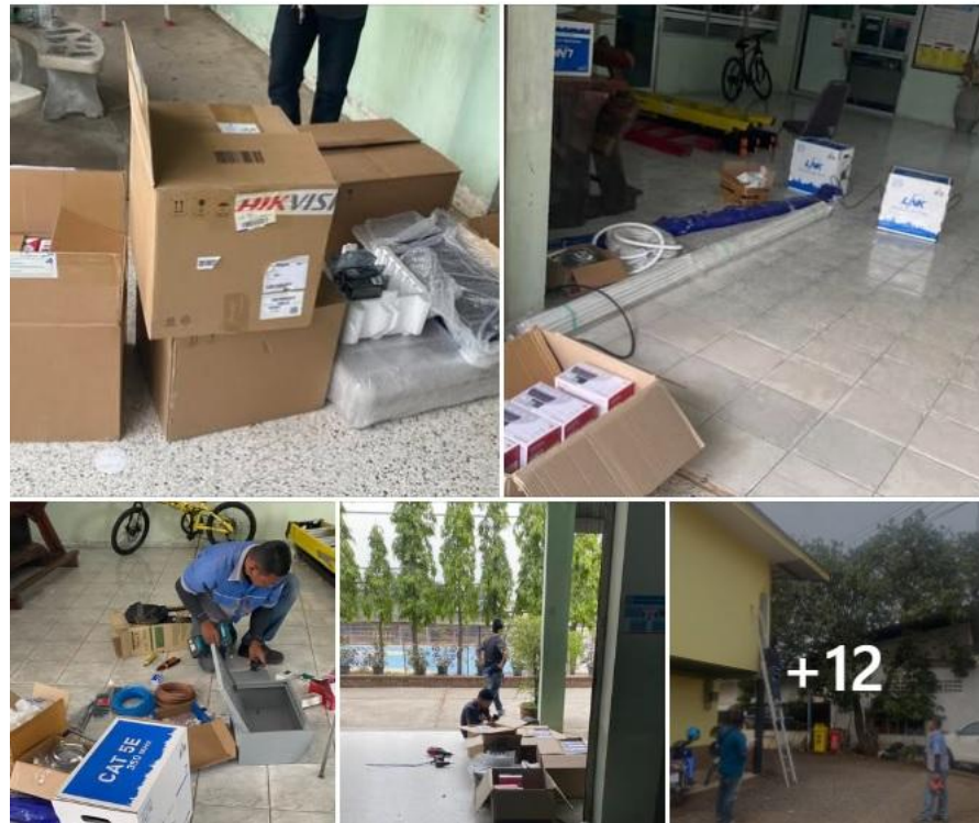
ติดตั้งกล่องวงจรปิด ด้านหลัง day 1-2
